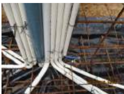
Figura 4. Actividad tendida de tuberías eléctricas Mz20-Sl10 Urb. Fuentes del Rio.
