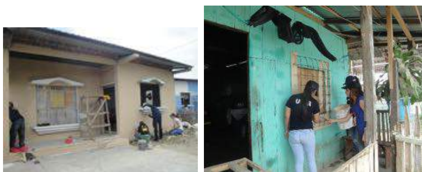
Foto 3. Pintando fachadas de viviendas Foto 3. Pintando fachadas de viviendas
