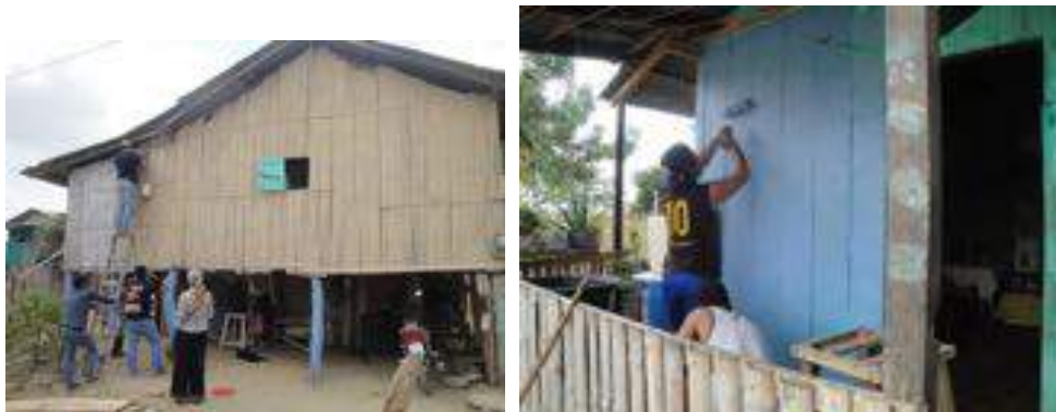
Foto 3. Pintando fachadas de viviendas Foto 3. Pintando fachadas de viviendas
