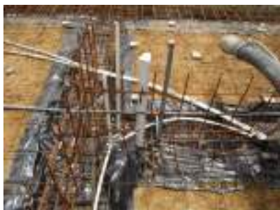
Figura 3. Actividad tendida de tuberías sanitarias de AASS y AAPP Mz20-Sl10 Urb. Fuentes del Rio.
