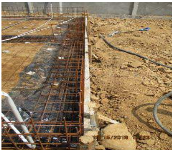
Figura 2. Actividad colocación de estructuras en cimentación Mz20-S110 Urb. Fuentes del Río.
