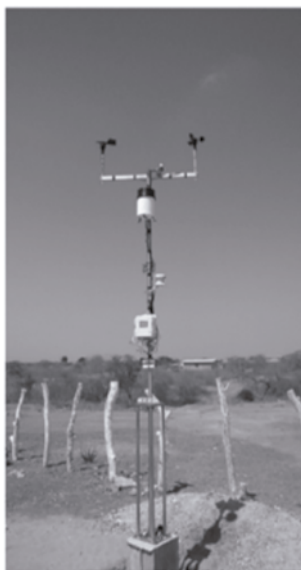
Figura 2. Estación meteorológica instalada en Atahualpa. Los sensores permiten la medición de las diferentes variables involucradas en el estudio.
